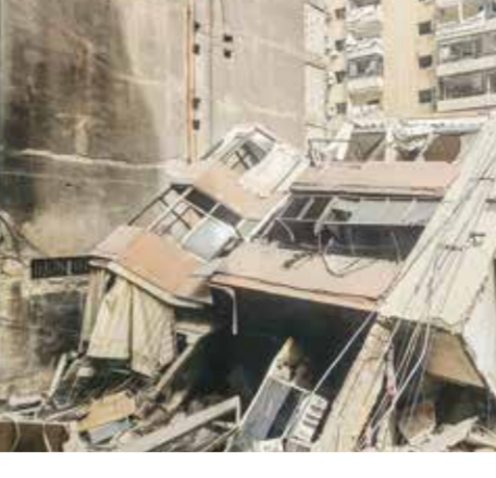
○ مبنى سكني في حي حارة حريك بالجنوب اللبناني دُمّر في غارة ليلية، (أ ف ب)
