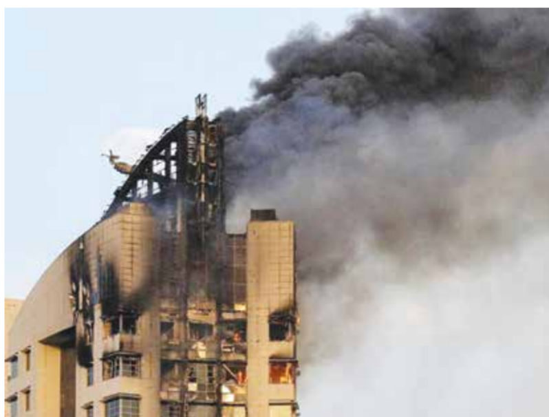
○ دخان كثيف يتصاعد من مبنى إثر اعتداء إيراني بمسيرة. (أرشيفية)
