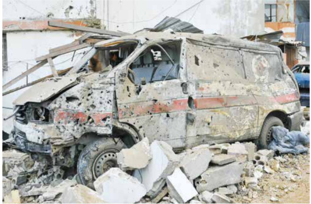
○ دمار في مركز الإسعاف ببلدة الهبارية الذي استهدفه القصف الإسرائيلي. (أ ف ب)
