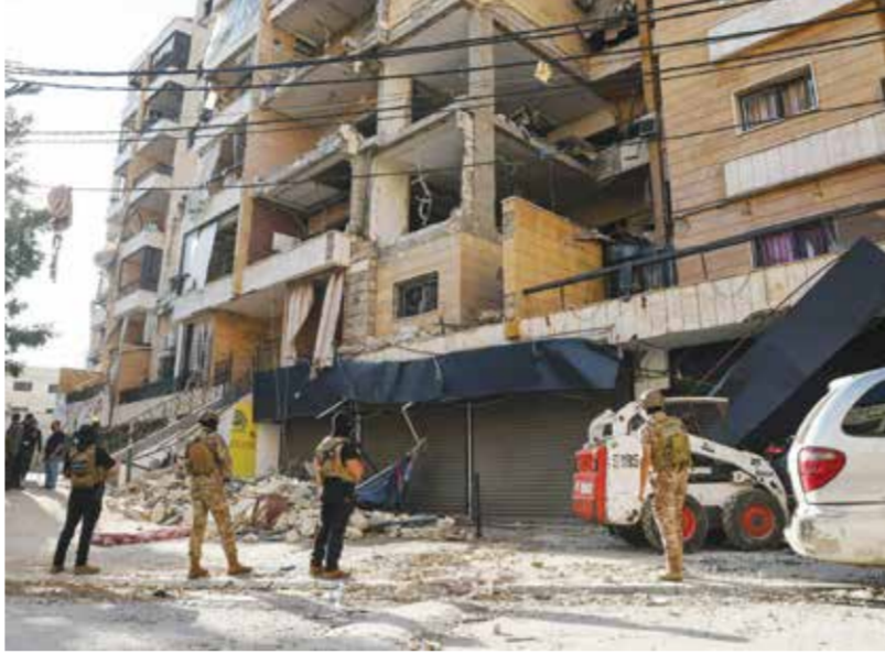
○ فريق إنقاذ عند مبنى تعرض لغارة إسرائيلية في الضاحية الجنوبية لبيروت. (رويترز)
