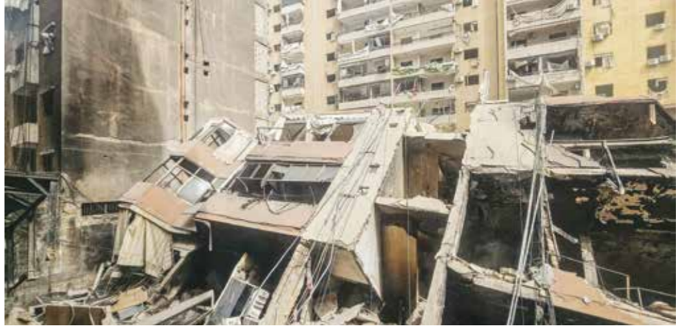
○ مبنى سكني في حي حارة حريك بالجنوب اللبناني دُمّر في غارة ليلية، (أ ف ب)
