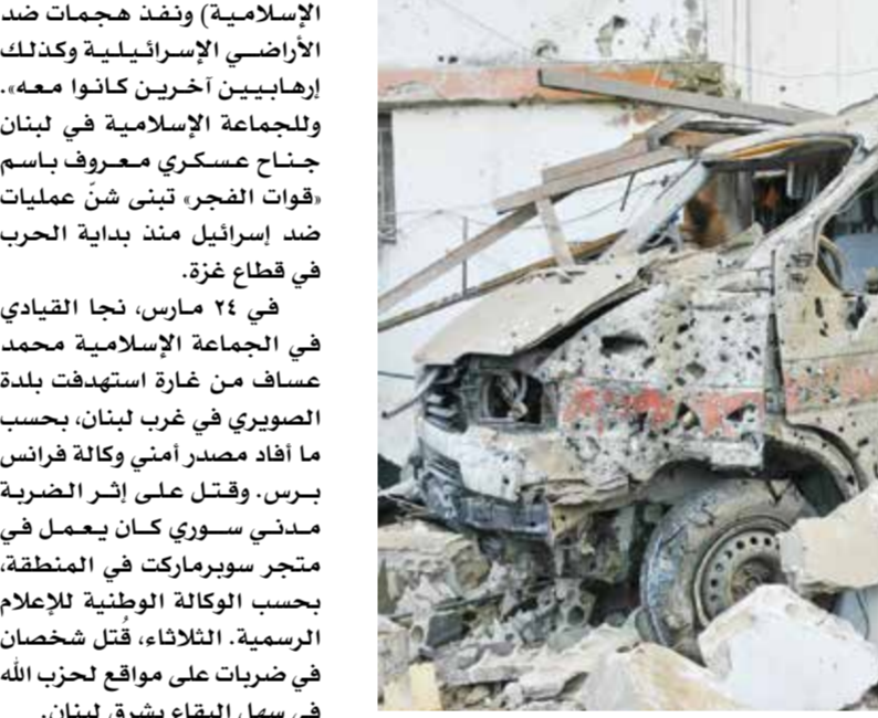
○ دمار في مركز الإسعاف ببلدة الهبارية الذي استهدفه القصف الإسرائيلي. (أ ف ب)
